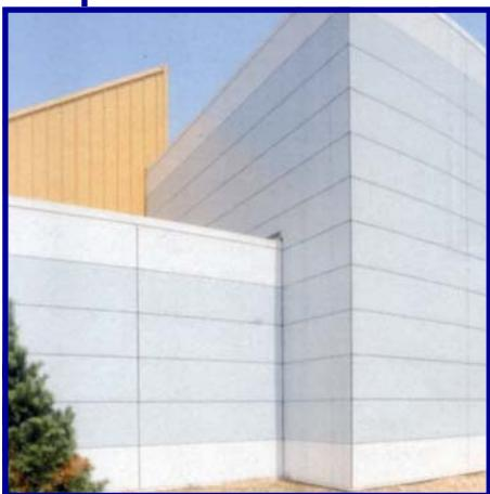
**FRIMET BT-LM** je metalni samonosivi panel s izolacijom od PUR pjene i spojem na labirint trakaste profilacije. Namijenjen je za izgradnju skladišta i frigo-komora s niskom temperaturom.
